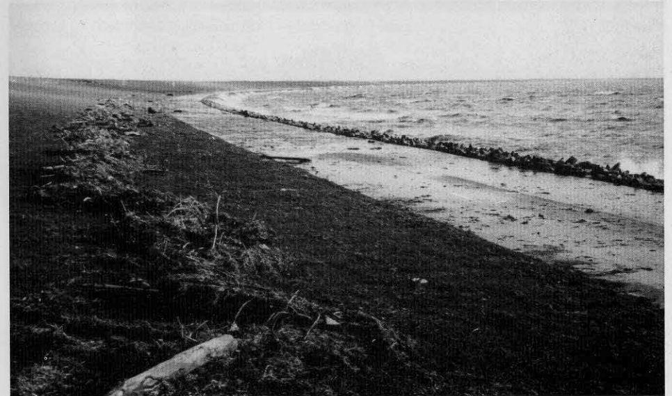
Nach einer Sturmflut am neuen Deich in der Melderer Bucht – Spülsaum.
