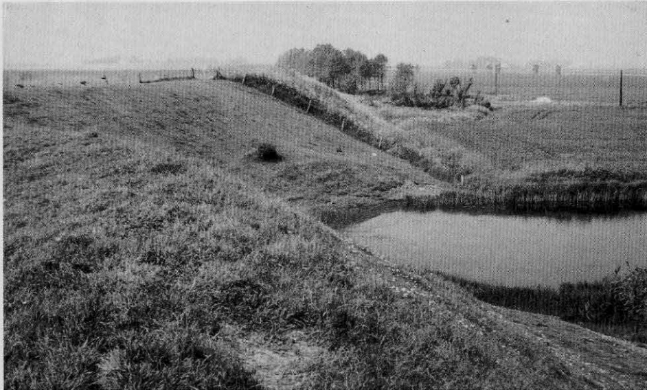
Das Wehl und der Verlauf eines alten Deiches (mit steiler Innenberme) erinnern an einen früheren Deichbruch. Im Hintergrund die Marsch mit baumumstandenen Höfen.
